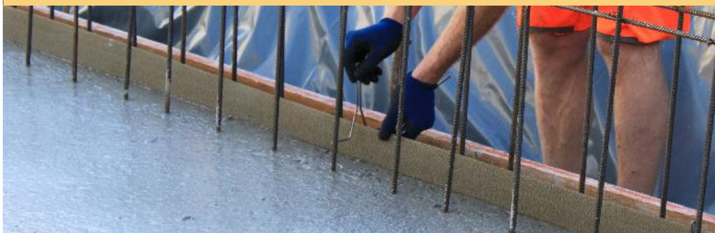
Профила се фиксира и укрепва с монтажните скоби
