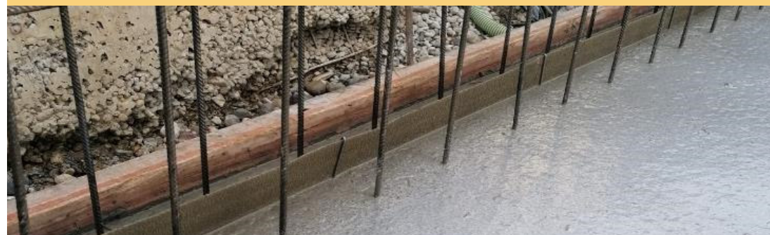
Монтажните скоби задържат профила на неговото място
